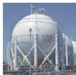
大井川港基地 (LPG二次基地)
